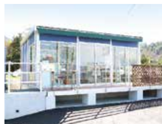
管理人が常駐している 管理事務所
